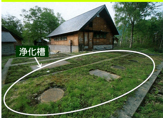
公衆トイレに設置されている合併処理浄化槽 (山ノ鼻公衆トイレの裏)
